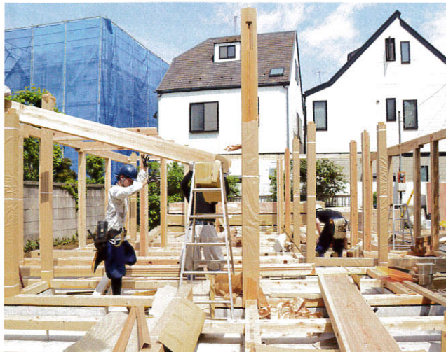
民家型住宅T邸の上棟現場
