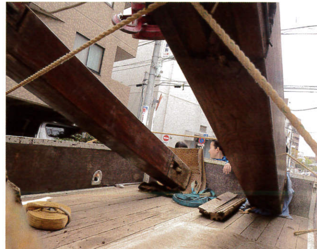
解体現場から古材運搬
