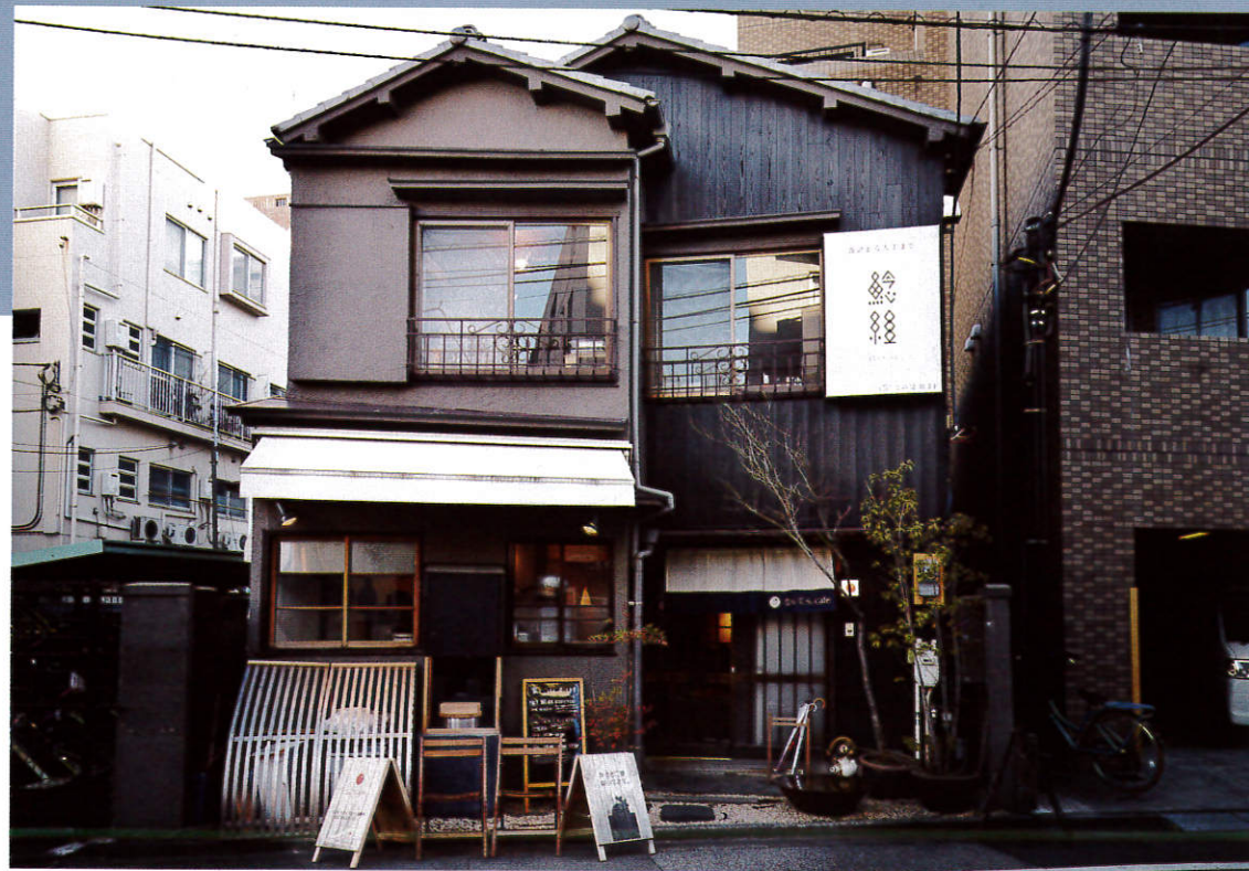
古民家を改装した鯨組の事務所。1階が「なんてんcafe」
